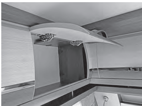
Kłapa szafki z mechanizmem Soft-Close
