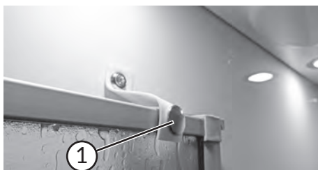
Zabezpieczenie transportowe przegrody prysznicza
