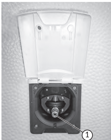
Przyłącze do wody miejskiej
